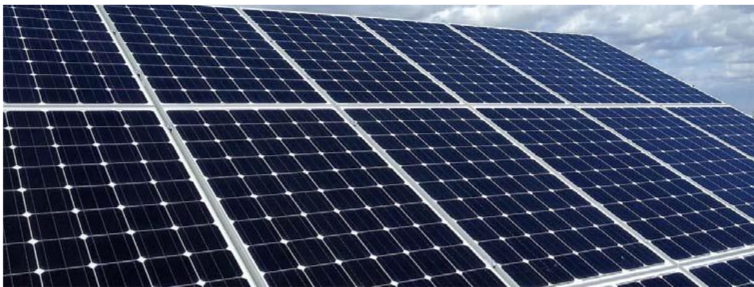
Figura 7: Pannelli fotovoltaici in silicio monocristallino.
