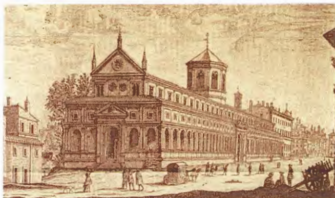
Complesso monumentale S. Spirito
